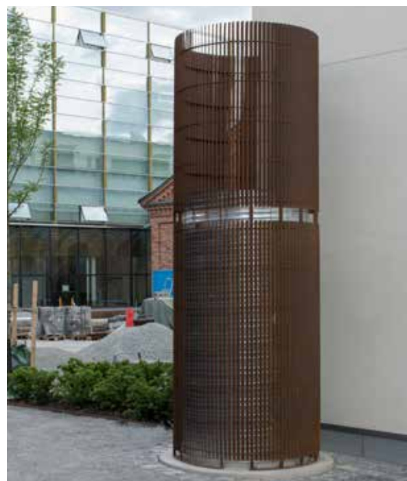
Tuuletusrumpua suojaava A-ritilä erityisellä silmäkoolla. Valmistaja Cortén.
